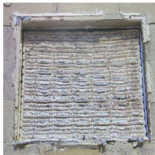
Face exposée après l'essai.
