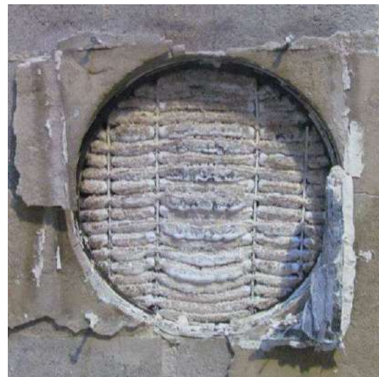
Face exposée après l'essai.
