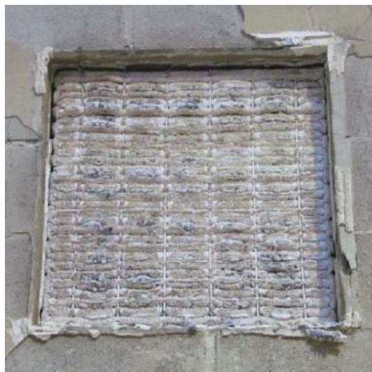
Face exposée après l'essai.
