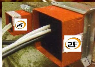
Les passe-câbles coupe-feu sont des goulottes qui permettent de restituer l'intégrité coupe-feu d'un voile ou d'une dalle coupe-feu au niveau des traversées de câbles électriques.
